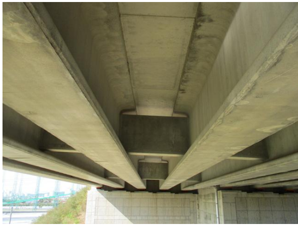
거더 및 바닥판하면 전경
