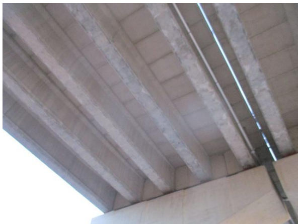
거더 및 바닥판하면 전경
